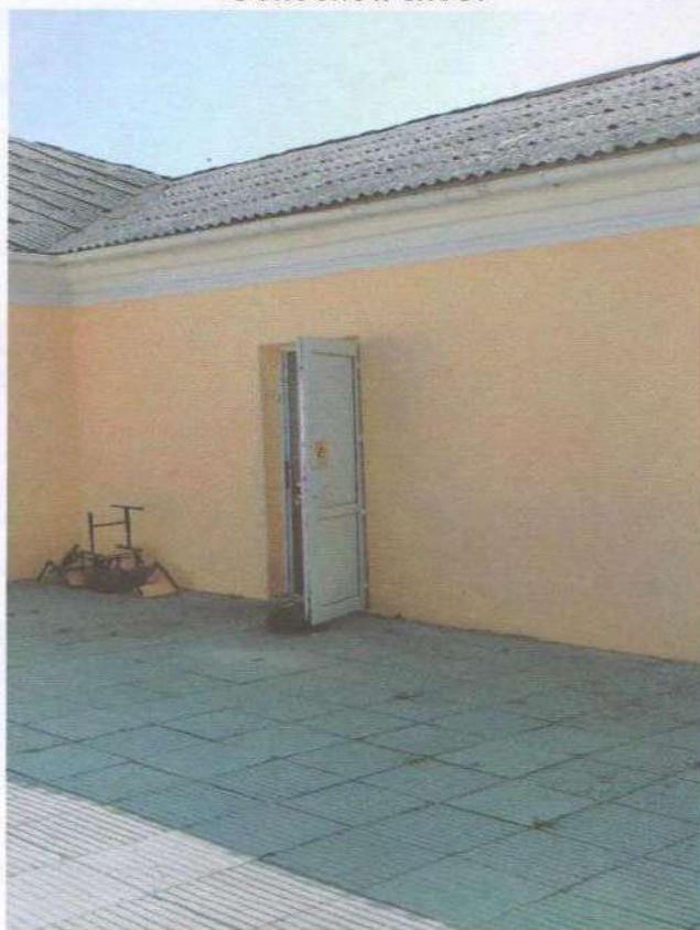
Запасной вход с расширенной дверью.
